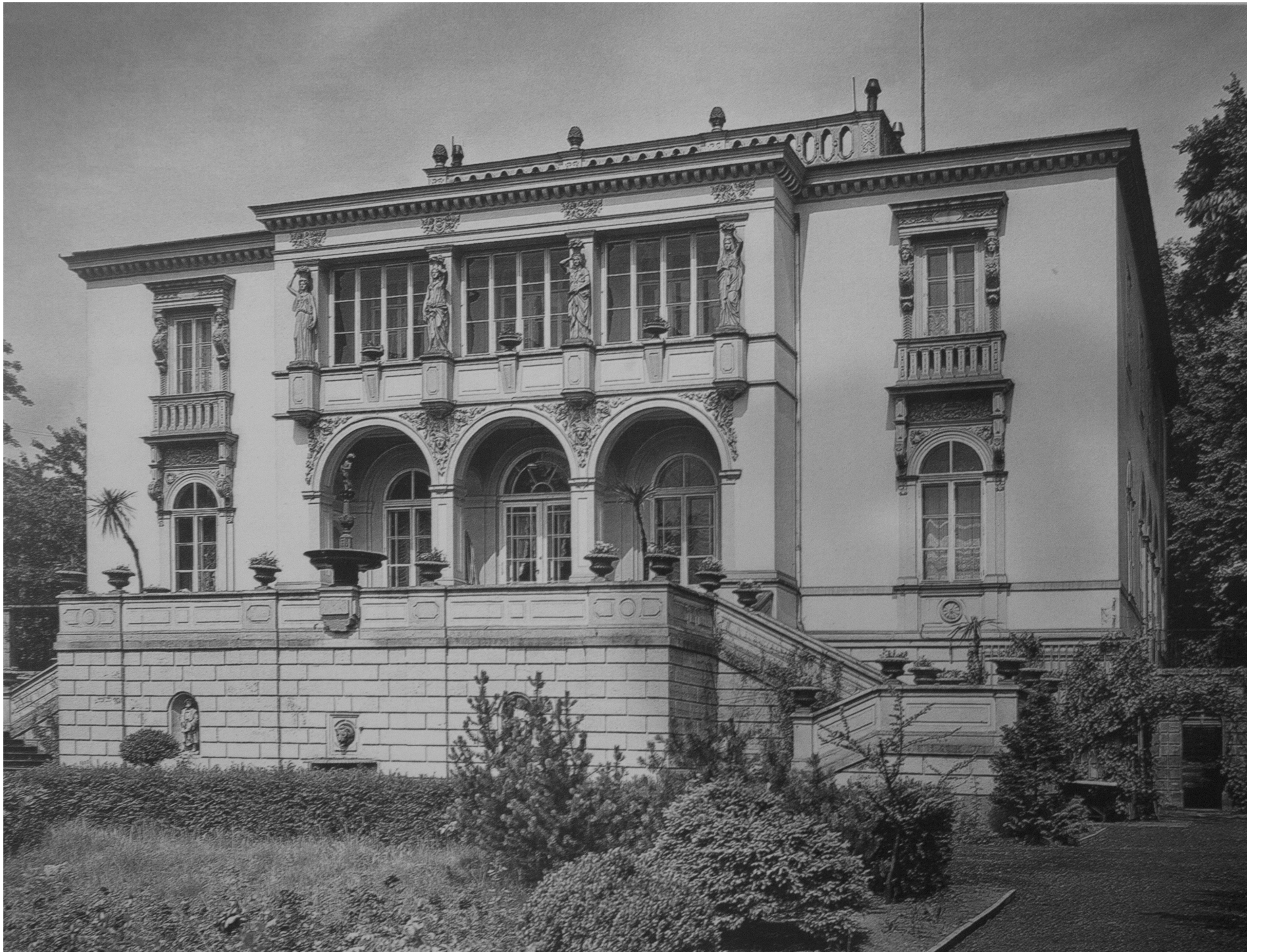
Abb. 1: Gottfried Semper: Südseite der Villa Rosa, Dresden 1935.
